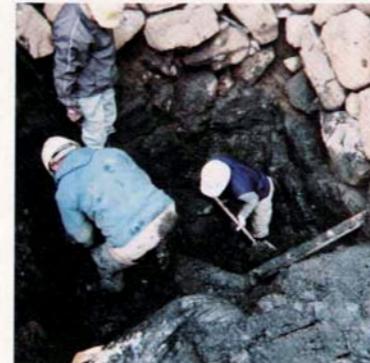
入隅掘削の様子 根石の確認調査を実施した際、下方へ続く石垣を発見
