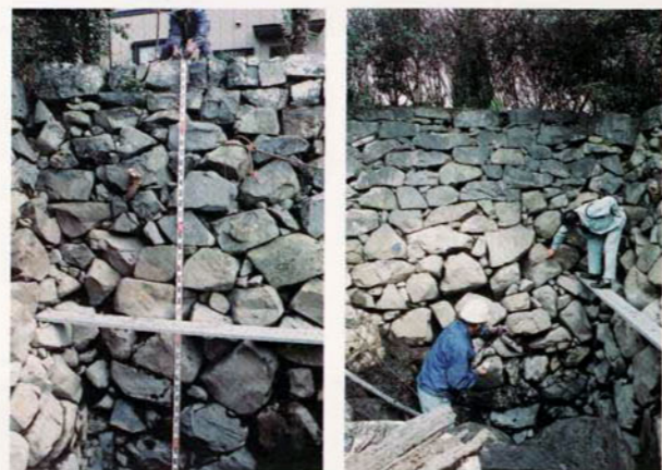
平成15年3月に実施された三之丸堀石垣調査の様子
