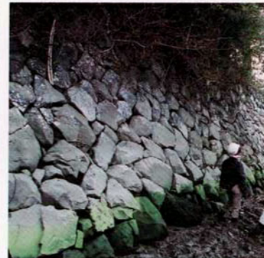
石垣調査の様子 堀水をせきとめ堀底の土を掘削しました
