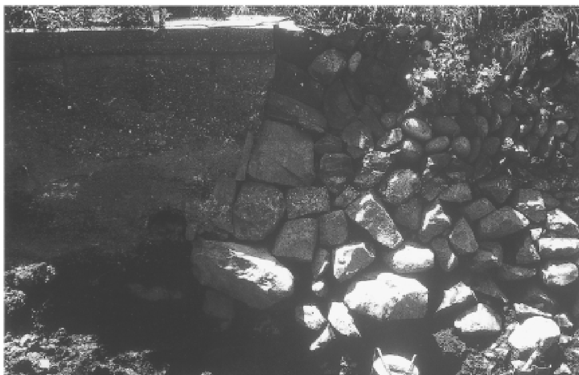
㊤石垣立面角石検出状況
