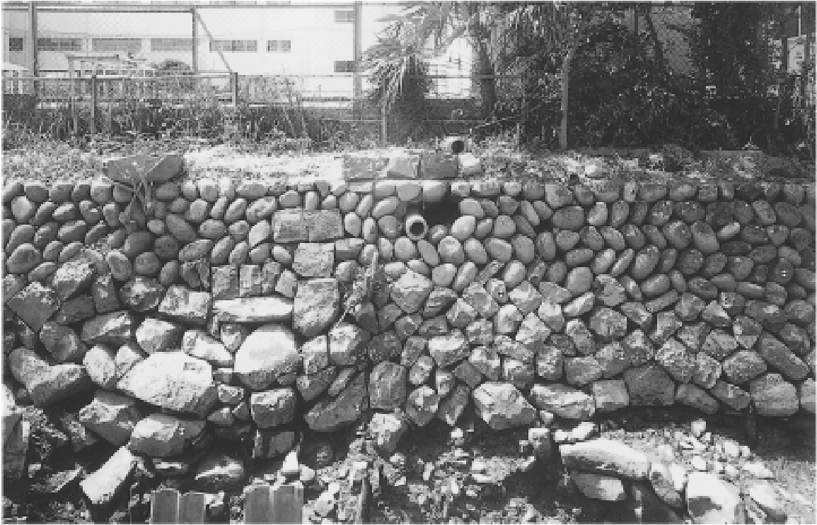
㊤石垣立面東端検出状況
