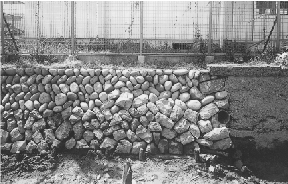
㊦石垣立面西端検出状況
