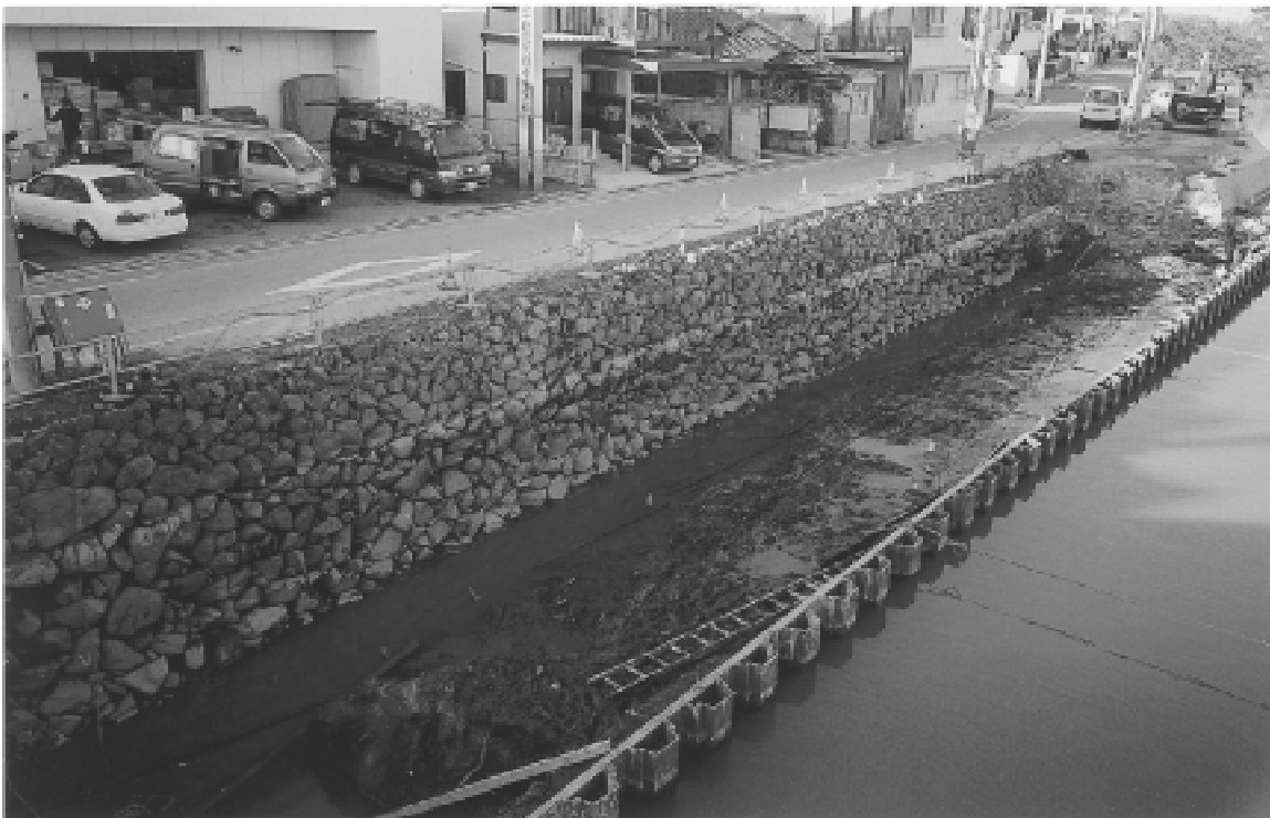
◎石垣北半部全景
