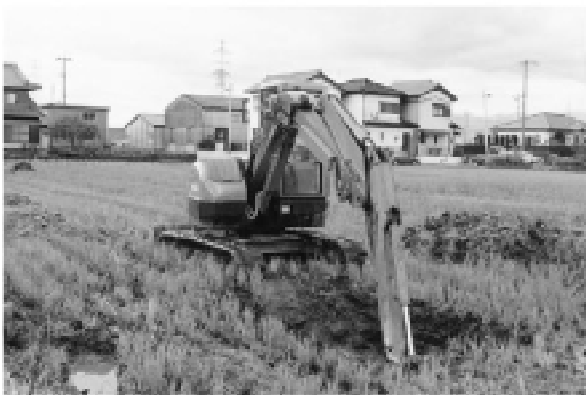
試掘 作業風景
