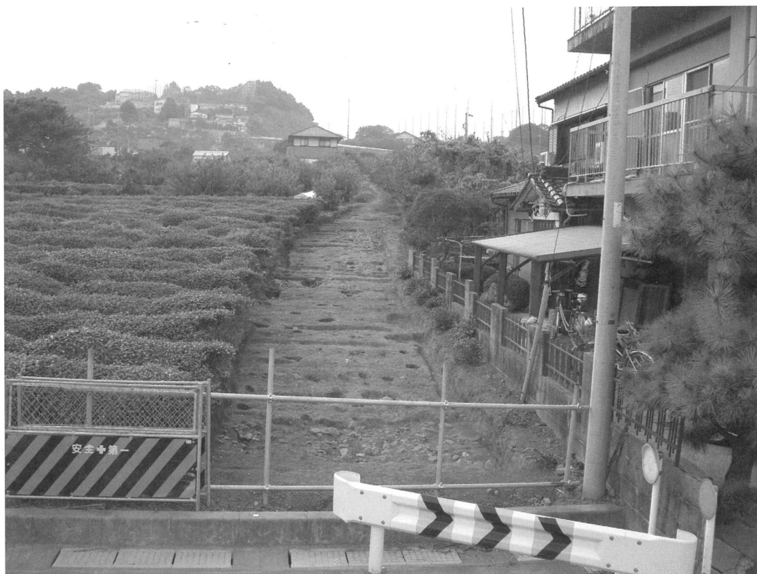
前半区完掘状況（東から）
